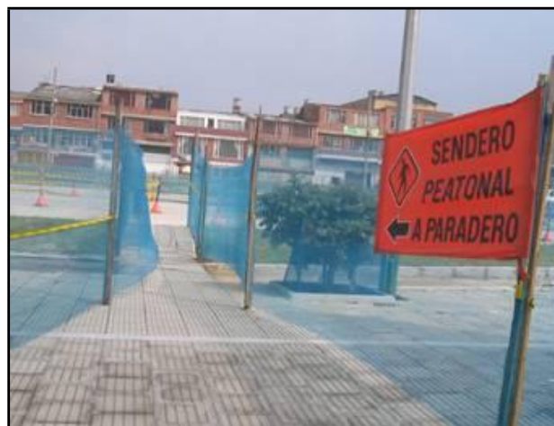
Figura 8.19 Señalización de Tránsito Peatonal
